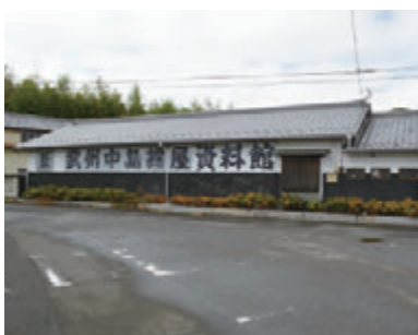
工房に併設された資料館
